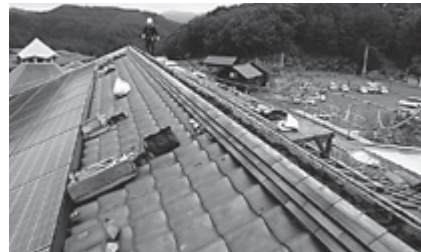
▲役場庁舎屋根修繕の様子
