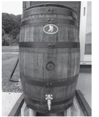
▲ウイスキー樽を再利用した雨水タンク
