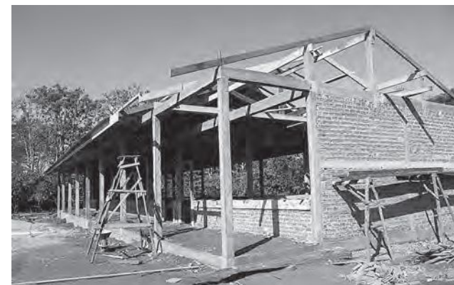
▲村が支援し建設中のドンニャイ中学校
