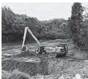
▲ため池の除染の様子
