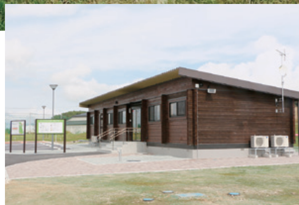
駐車場に隣接する管理棟
