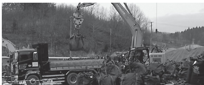
▲除染廃棄物搬出の様子
