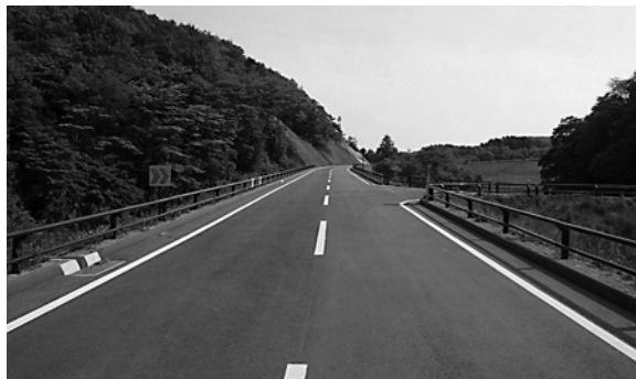
▲改良工事が行われた「大火比曾線」
