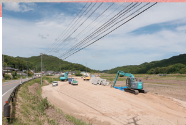
県道原町川俣線ではバイパス工が進みます
