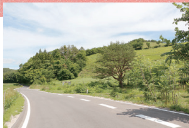
野手上の山すその村道でも舗装を進めています
