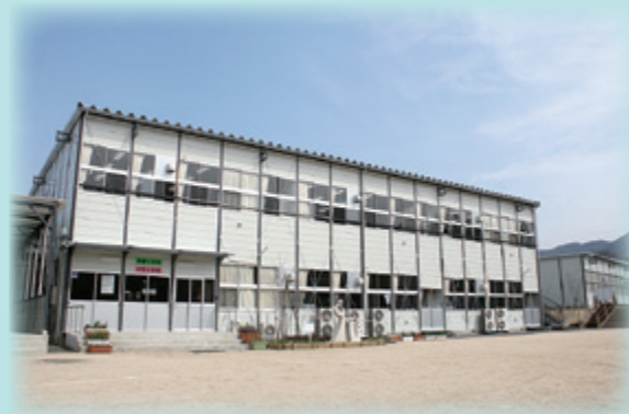
草野・飯樋・白石小学校 仮設校舎 (平成24年度～平成30年度)
