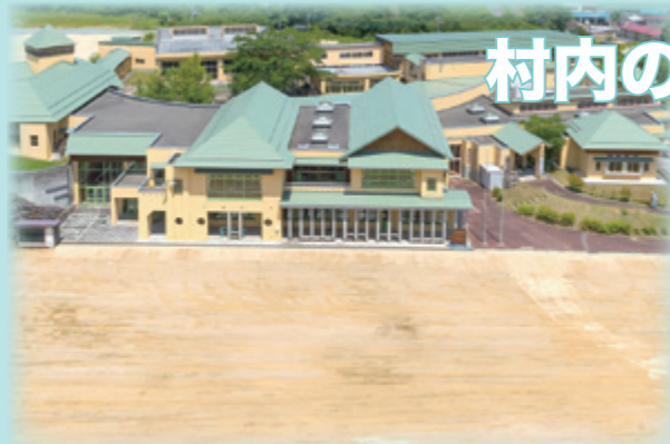
飯樋小学校 校舎
