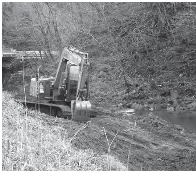
▲河川の土砂撤去
