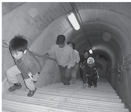
▲ダム監査廊を探検
