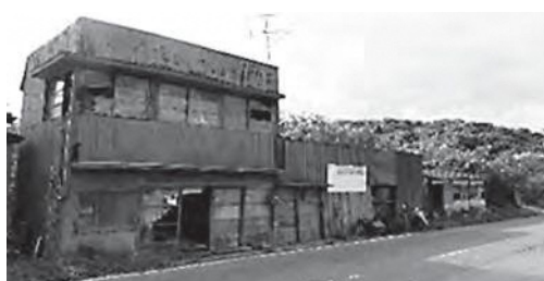
▲解体を必要とする建物
