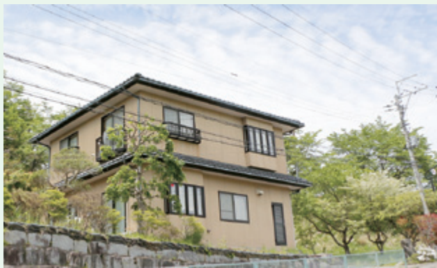
草野地区に整備されたお試し住宅。移住を検討する人が実際に住んでみるための住宅です。問い合わせは村移住相談室まで。(e ライフセンター-いいたて) ☎0244-42-0310
