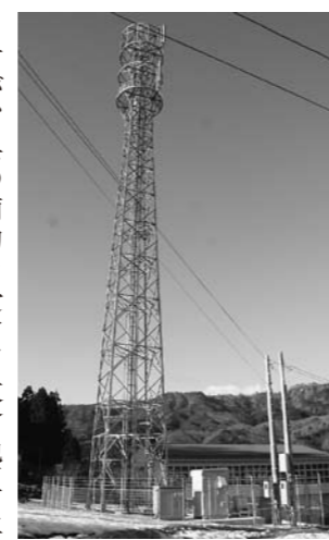
▲大倉地区に完成した高さ40mの鉄塔施設
