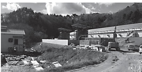
▲問題になっている施設
