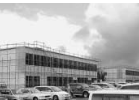
▲新設中の製品保管庫
