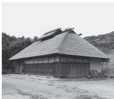
▲屋根の葺き替えが終了した民家園
