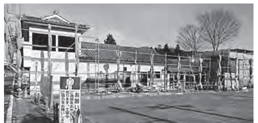
解体中の家屋
