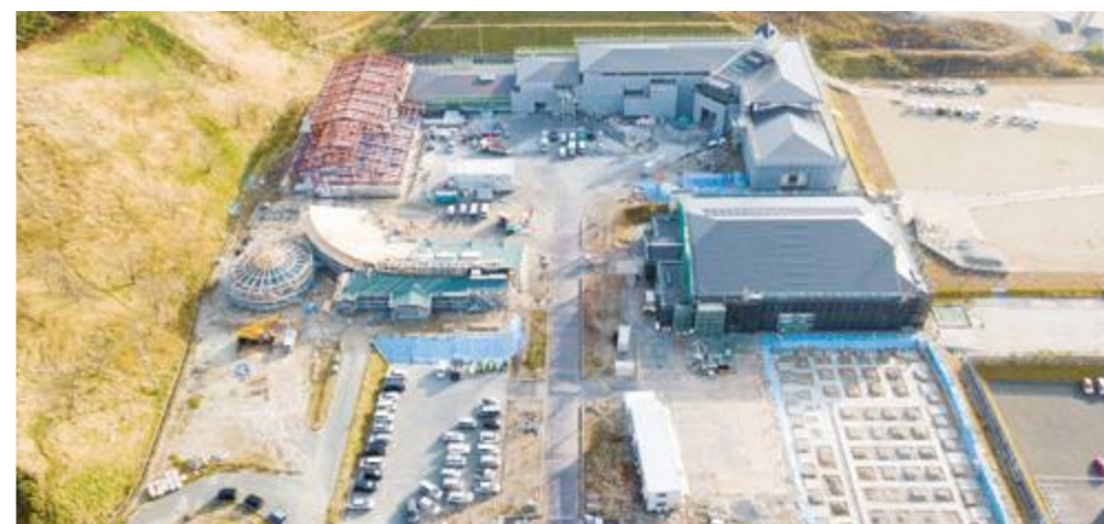
▲来年4月からの学校再開に向け、学校施設の改修工事が進んでいます
