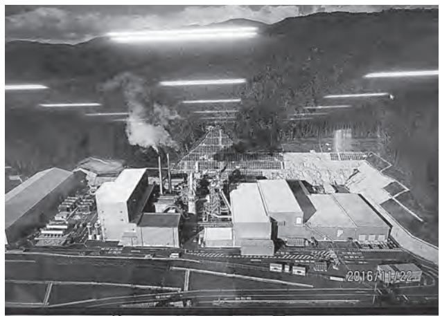
蕨平地区仮設焼却施設の全景
