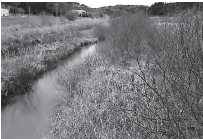
堆積除去が待たれる、雑草・樹木が繁茂した河川
