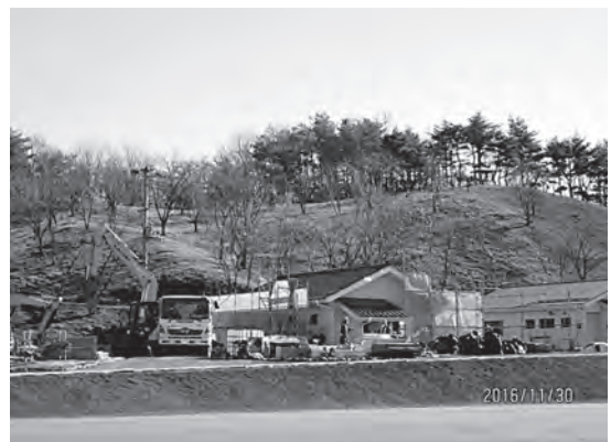
解体中(12月解体済)の教員住宅(飯館中学校)
