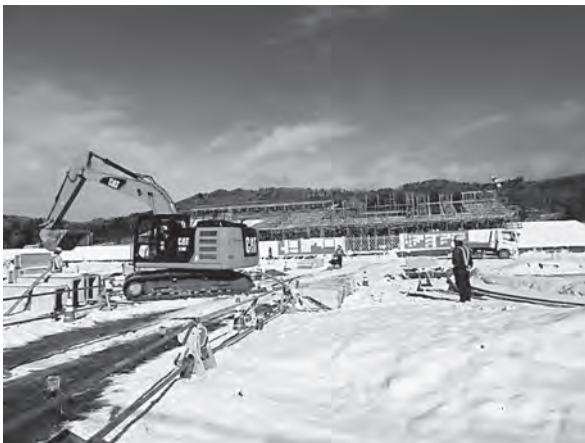
道の駅「までい館」の建設状況
