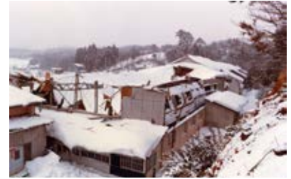
降り積もった雪の重みでつぶされた屋根
