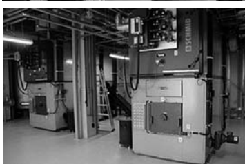
北海道下川町 木質バイオマスボイラー
