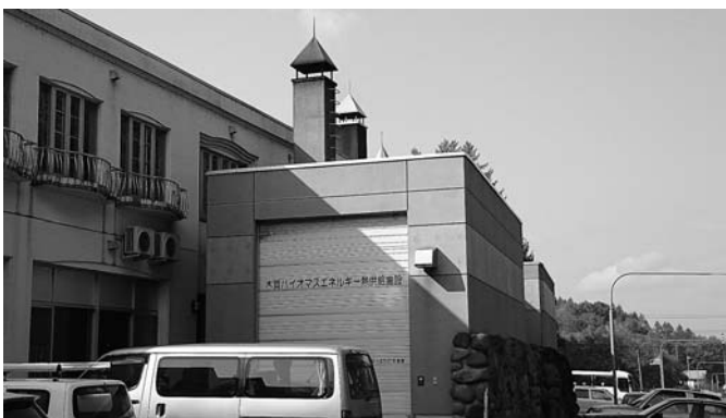
北海道下川町 木質バイオマスエネルギー 熱供給施設
