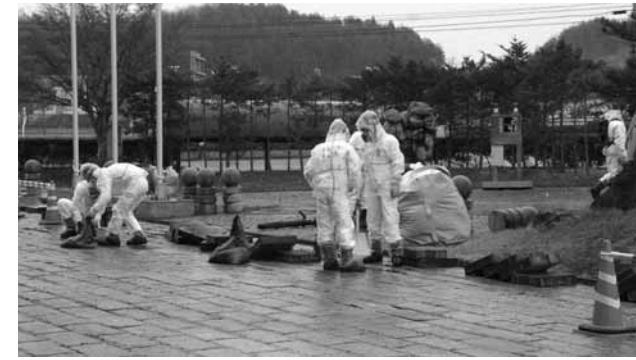
▲村役場本庁舎の除染のようす
