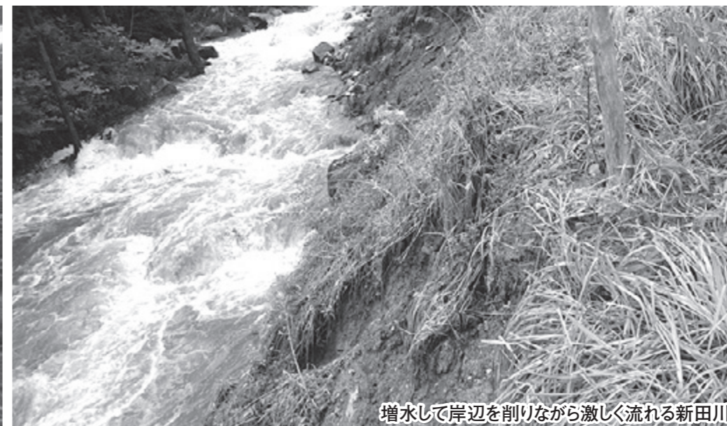
水の流れに削られ路肩から崩落(三ツ森道路)
