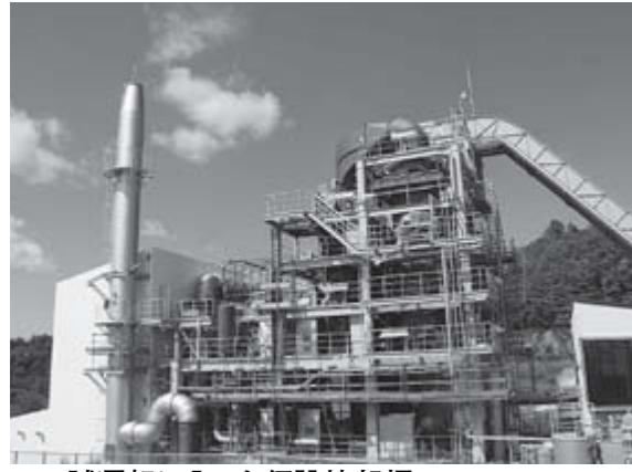
▲試運転に入った仮設焼却炉
