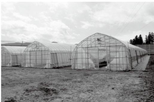
福島市荒井地内に設置されたパイプハウス
