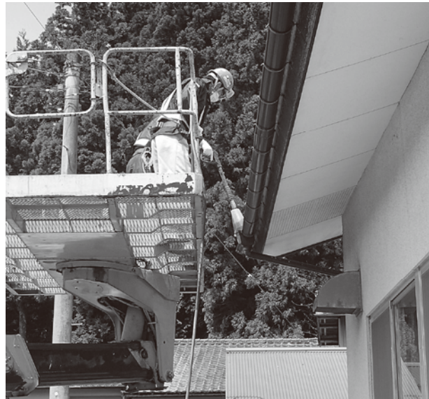
▲縦樋を高圧洗浄で除染します
