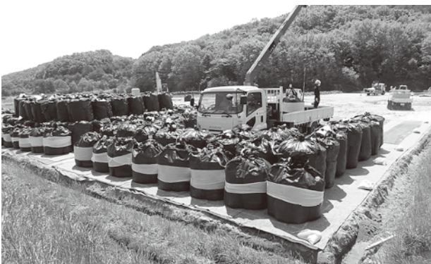
▲須萱地区の仮仮置き場にフレコンバックを搬入するようす
