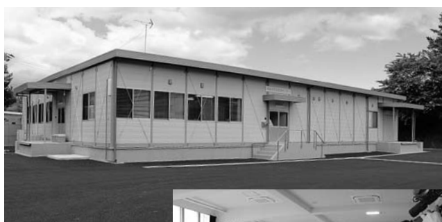
▲完成した給食センター
