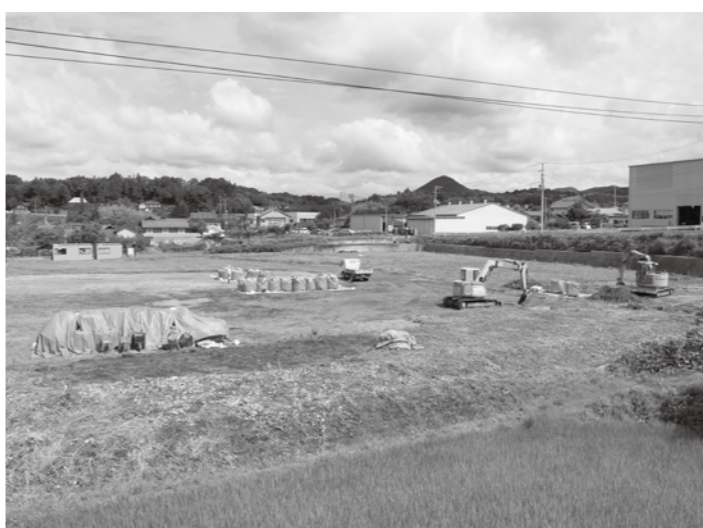
▲敷地内の除染が始まった建設予定地(福島市飯野町)
