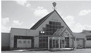
▲JAふくしま未来が取壊し後、飯館村が土地を造成
