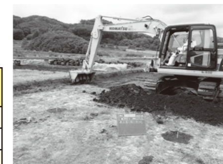
▲バックホーでの表土削り取り
