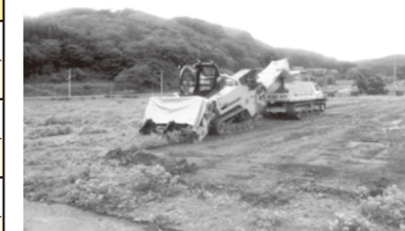
▲スキマー工法での表土削り取り
