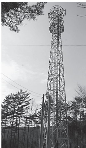
▲蕨平地区に建設された鉄塔
