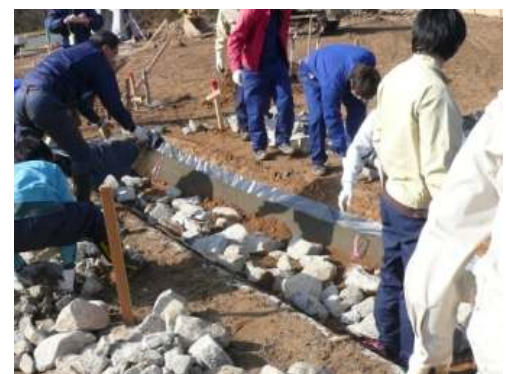
土壌と石の敷設
