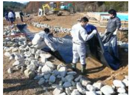
防水シートの敷設
